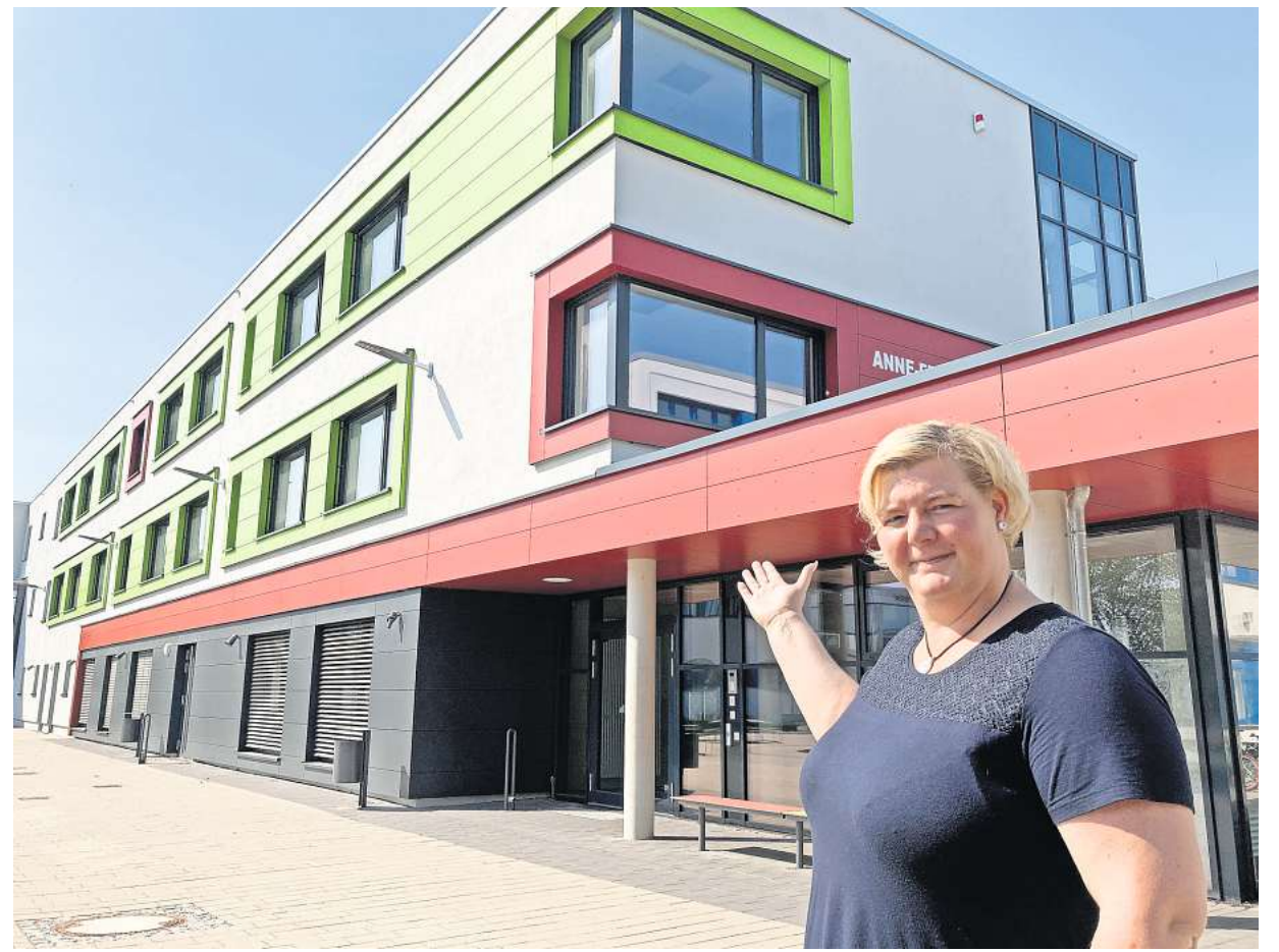
Bürgermeisterin Susanne Dräger (42) zeigt stolz einen Teil des sanierten und umgebauten Schulgebäudes. Insgesamt ist für sieben Millionen Euro ein Campus für Grund- und Regionalschüler entstanden.
