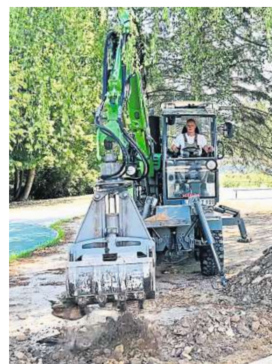
Bis zum Schulanfang erfolgen Arbeiten an den Außenanlagen.
