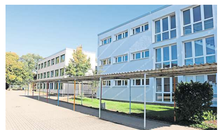
Die Regionale Schule mit Grundschule Buchenberg soll einen Neubau mit Klassenräumen und Kantine erhalten.
