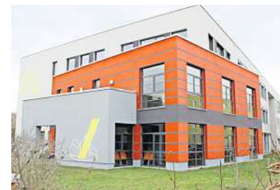
Dieses Gebäude der Montessorischule am Gedsering wurde im Jahr 2013 fertiggestellt.
