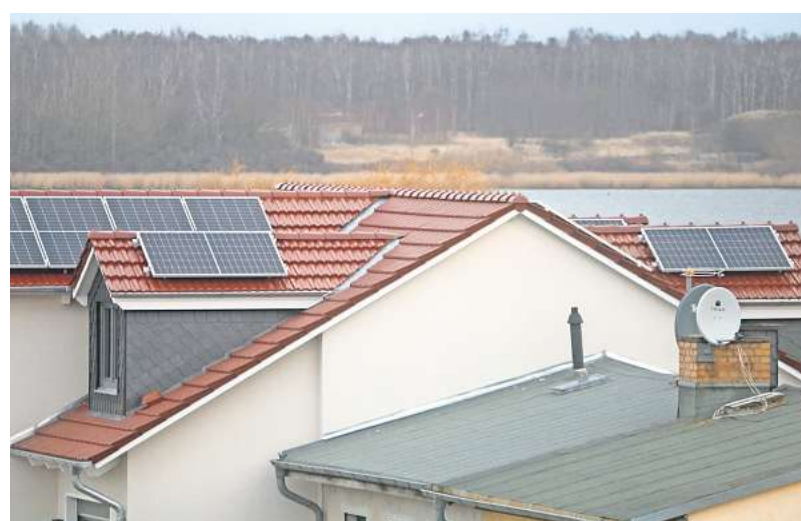
Zu den Solaranlagen, die vergangenes Jahr in Ribnitz-Damgarten neu installiert wurden, gehört diese Anlage in der Ribnitzer Altstadt. FOTO: E. STERNKIKER
