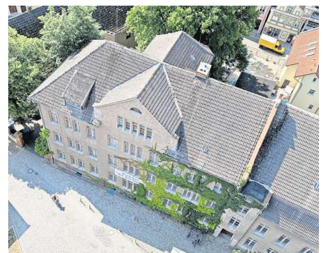
Die Sanierung des historischen Schulgebäudes am Wolgaster Kirchplatz ist unklar: Der Eigentümer sieht sich außerstande, die Baukosten alleine zu stemmen.
