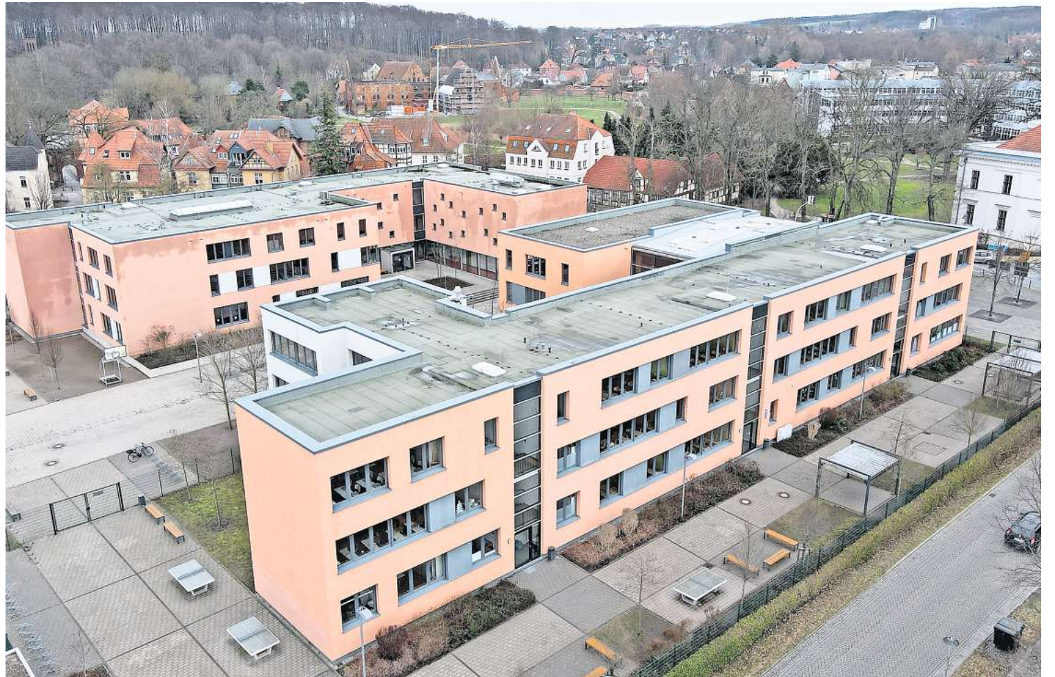
Die Lessing-Grundschule in Bad Doberan soll für 1,8 Millionen Euro einen Neubau auf dem Gelände bekommen.
